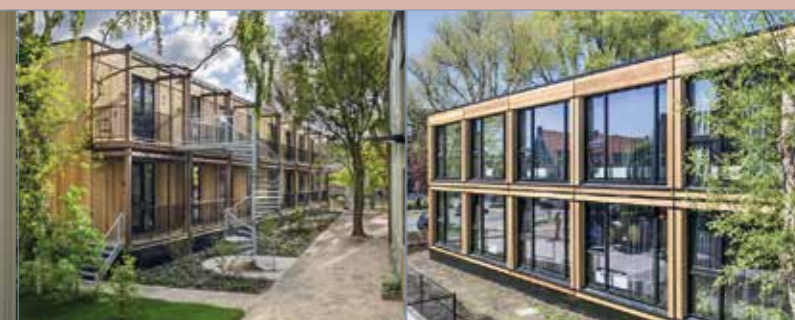
De 16 verplaatsbare Finch-woningen van Ons Doel in Leiden ^
